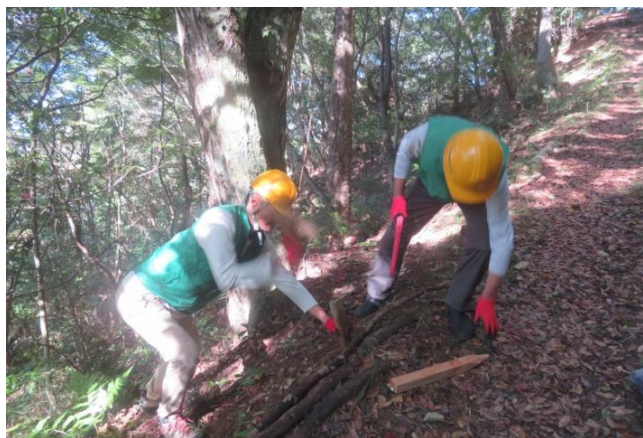
崩れた路肩を補強し直している田中さんと川島さん。
