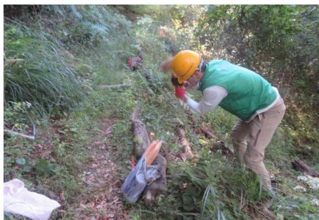
路肩を据え付けるために木の杭を打ち込んでいる畠中さん。
